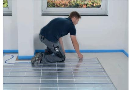
Mit Reststück ( $\geq 20$  cm) im schleppenden Verband beginnen (Fugenversatz  $\geq 20$  cm).
