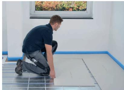
Das Element in der Nut-Feder-Verbindung zusammenschieben.
