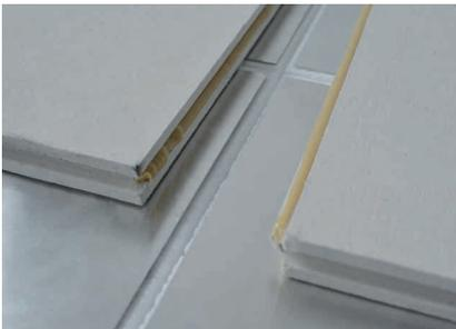
Unterseite der Nut als auch Oberseite der Feder jeweils mit einer Klebeschnur versehen. (ca. 10 m<sup>2</sup>/Kartusche).
