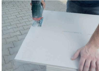
Letztes Element einer Reihe auf Länge kürzen (z.B. mit Kreissägeblatt Diamaster oder Stichsägeblatt T141 HM, Bosch).
